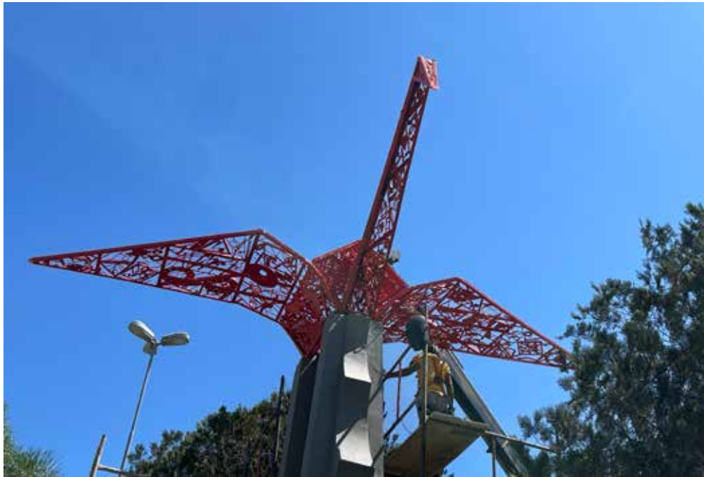
Obra "Amor e Paz" restaurada e instalada.
