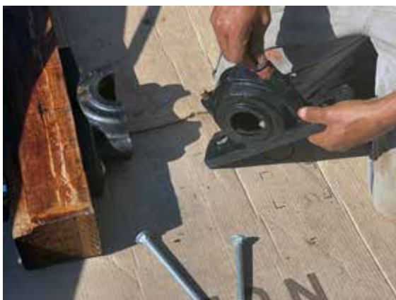
Obra transportada, partes içadas no Munck, montagem e fixação
